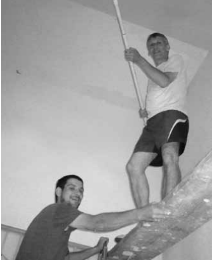
Im Sommer haben wir miteinander das Treppenhaus frisch gestrichen.
